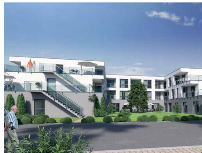
Im Mindener Stadtteil Königstor entstehen zwei ambulant betreute Wohngemeinschaften und 26 barrierearme Appartements. Quelle: GS projekt-bau
